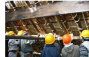
屋根内部作業のようす
