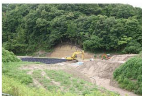
工事中の下水処理施設
